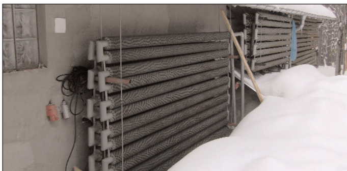
Durch die Kühlung des Schnei-Wassers - hier: die Kühlregister - liegt die Schneistart-Temperatur nunmehr bei (minus!) 4°C.
